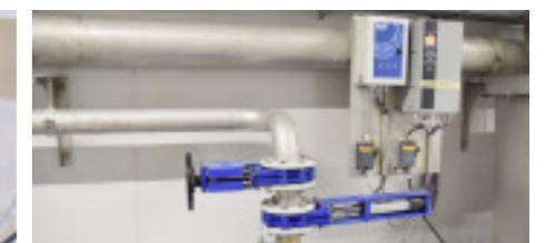
AVK spadeventiler med lineære aktuatorer på rør til rejektivand. De lineære aktuatorer er energieffektive sammenlignet med pneumatisk aktuatorer.
