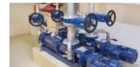
Slam fra bunden af afklaringszonen i DEMON®-tanken pumpes tilbage til processtankene som returslam, og overskydende slam pumpes ind i en cyklon, hvor anammox-bakterierne filtreres fra.
