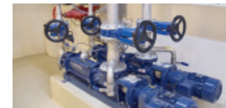
Slam fra bunden af afklaringszonen i DEMON®-tanken pumpes tilbage til procestankene som returslam, og overskydende slam pumpes ind i en cyklon, hvor anammox-bakterierne filtreres fra.
